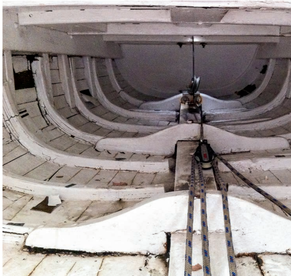
Beinahe alle Spanten sind delaminiert und gebrochen.
