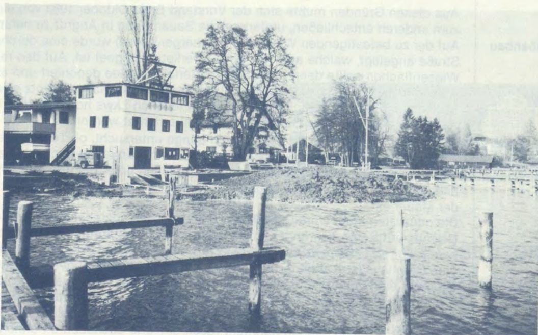
Das Fundament für den neuen Kran in Bau
